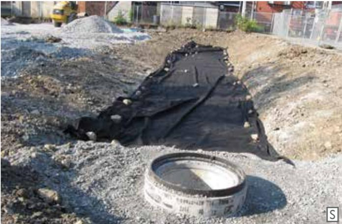
La photographie ci-haut a été prise lors de la construction de la cellule. On voit ici la position du géotextile ainsi que la présence d'un puisard au sein du système.
