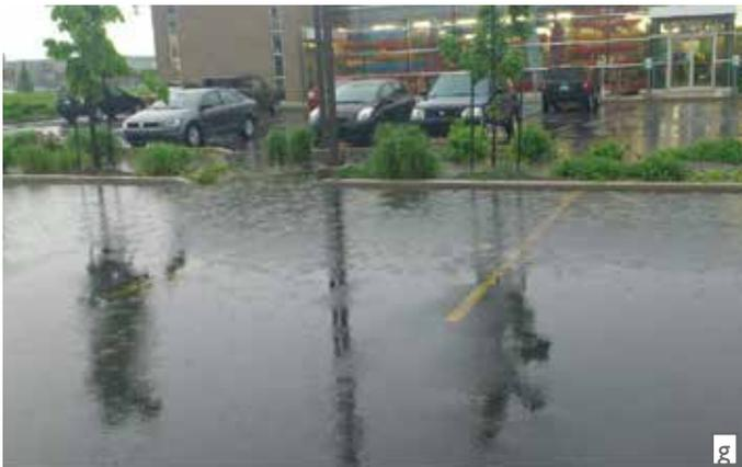
Exemple d'une cellule de biorétention inondée. Cette cellule, construite sur le site du MEC Longueuil, draine une surface tributaire de 3890 mètres carrés<sup>19</sup>.
