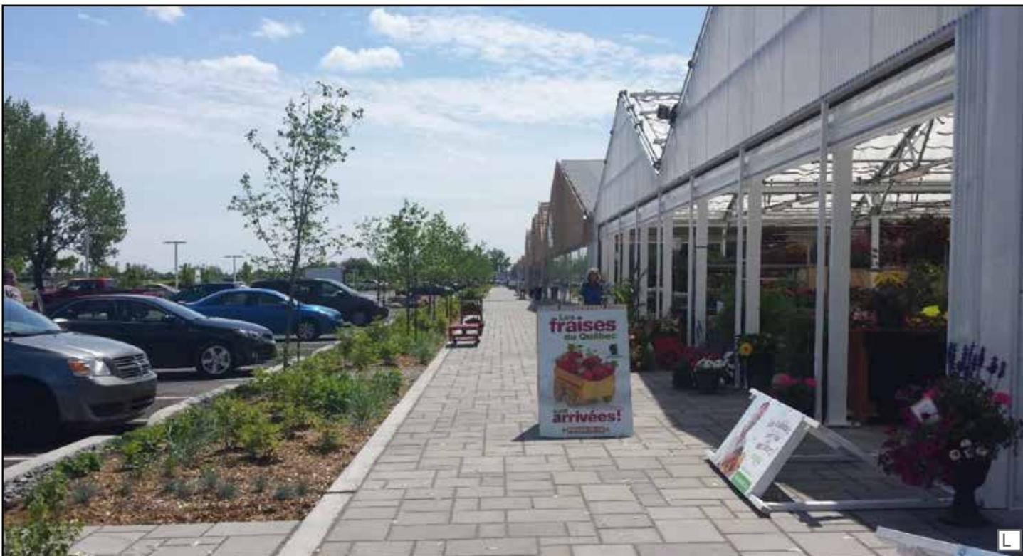
On observe ici le stationnement en façade avec un accès direct au marché. Une zone tampon est créée par les cellules de biorétention entre le stationnement et la voie piétonne.
