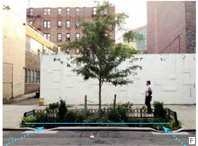
Figure 5: exemple de cellule de biorétention infiltrant les eaux pluviales sur place.
