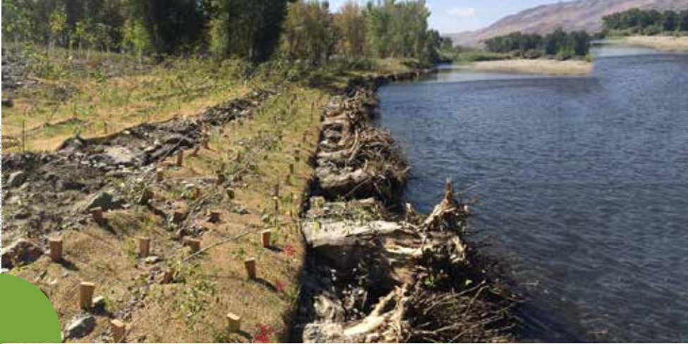
◀ Ouvrage de stabilisation d'une berge impliquant plusieurs techniques mixtes
