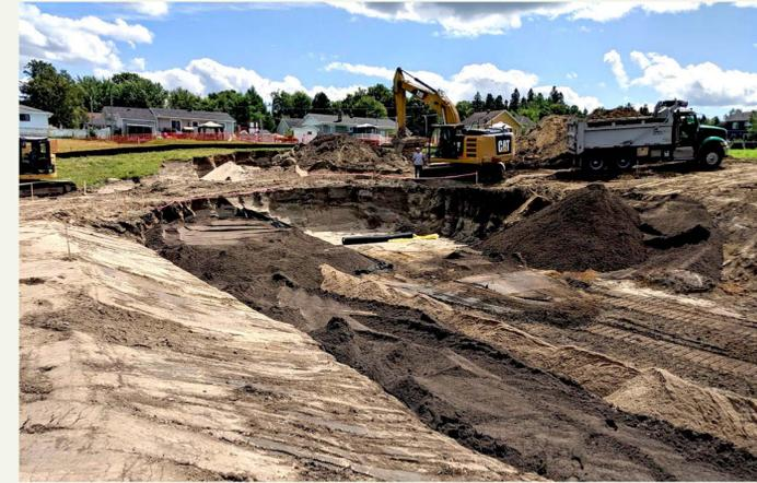
L'aire de biorétention est composée d'un drain perforé, de sable drainant et d'un substrat répondant aux exigences d'infiltration et de rétention des eaux. © William Verge (2019)
