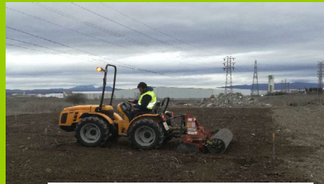
Préparation du site
