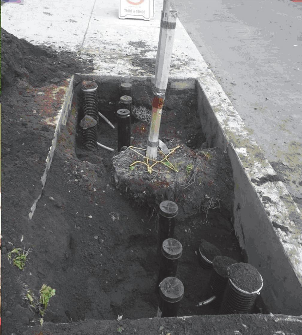
Mise en place de l'instrumentation pour prise de données et analyse en laboratoire
