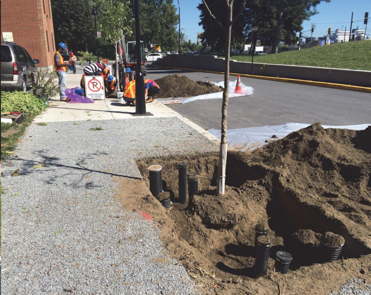
**Plantation d'arbre dans fosses avec instrumentation pour expérimentation sur la croissance des végétaux en présence d'un trottoir en béton drainant**
